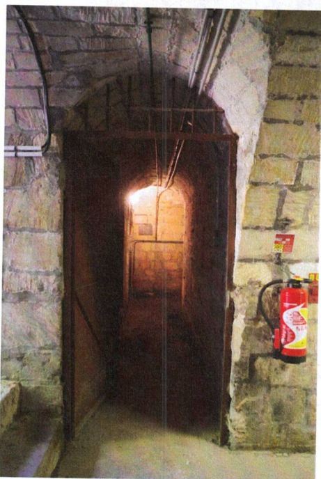
Bâtiment L - couloir reliant les deux caves
