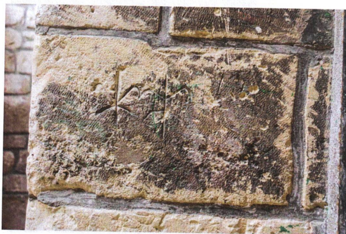
Bâtiment M - fleurs de lys (?) gravées dans le tableau gauche de la baie à coussièges E.A.10
