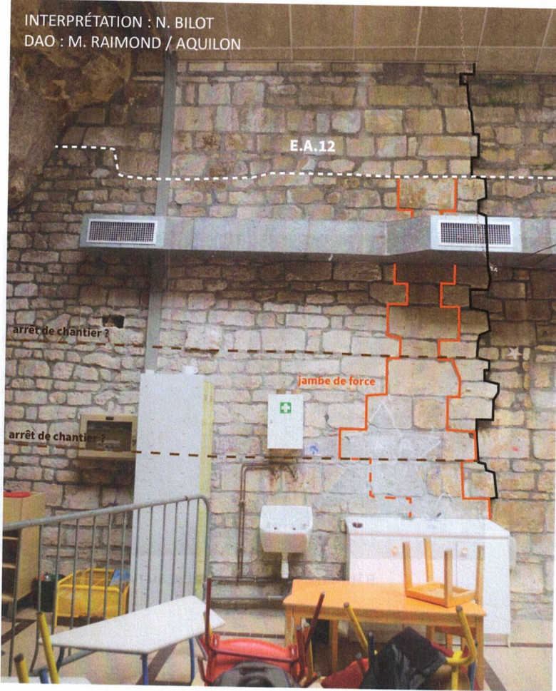
Bâtiment M - analyse archéologique du pan occidental du mur-gouttereau nord
