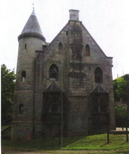
Bâtiment L - mur-pignon nord
