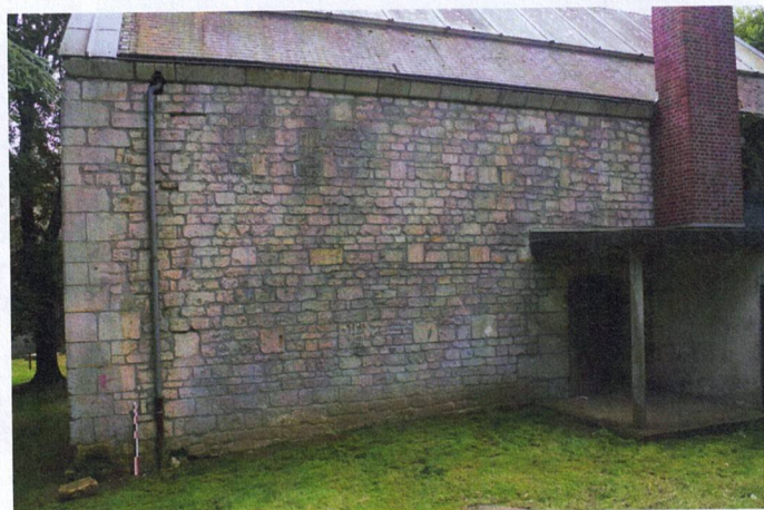
Bâtiment M - mur-gouttereau nord
