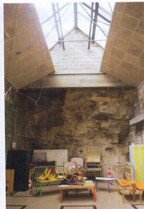
Bâtiment M - partie troglodytique
