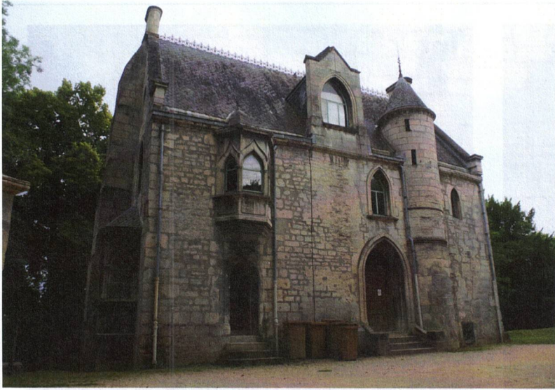
Bâtiment L - mur-gouttereau ouest
