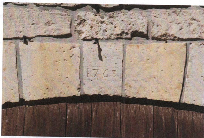
Bâtiment M - graffiti « 1763 » sur un claveau de la porte E.A.06
