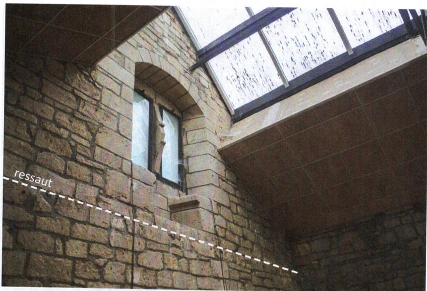
Bâtiment M - baie à coussièges E.A.11 avec meneau aménagé d'une colombe ; ressaut de maçonnerie
