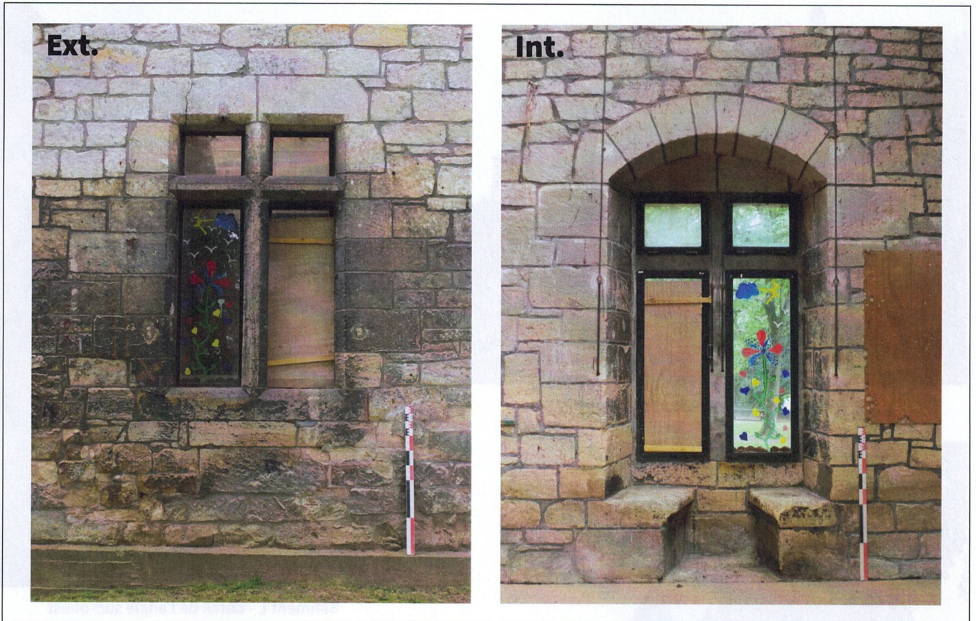
Bâtiment M - baie à coussièges E.A.10
