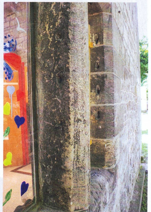
Bâtiment M - détail du barreaudage disparu de E.A.10
